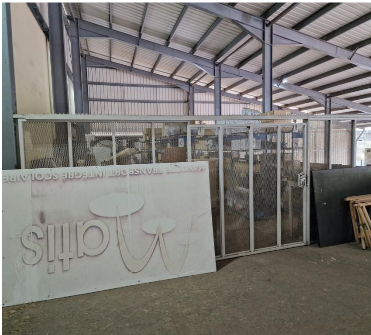
5 Photographie espace stockage et maintenance à l'étage
